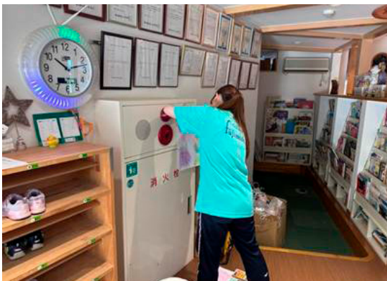
図4 消火栓でのフロッターージュ
