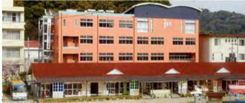
平成28年3月 高校総合実習棟竣工
